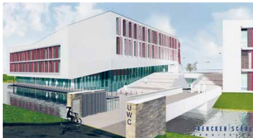
Artist impression van de schoolgebouwen van het UWC met op de voorgrond de voetgangers- en fietsbrug als toegang tot het kunstmatige eiland
