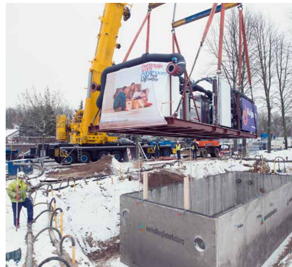
De plaatsing van de ‘clusterkelder’, een ondergronds uitwisselstation met warmtewisselaars, dat is aangesloten op het leidingnetwerk om warmte en koude te leveren. [foto: Nose for Photography, Pascal Moors]
